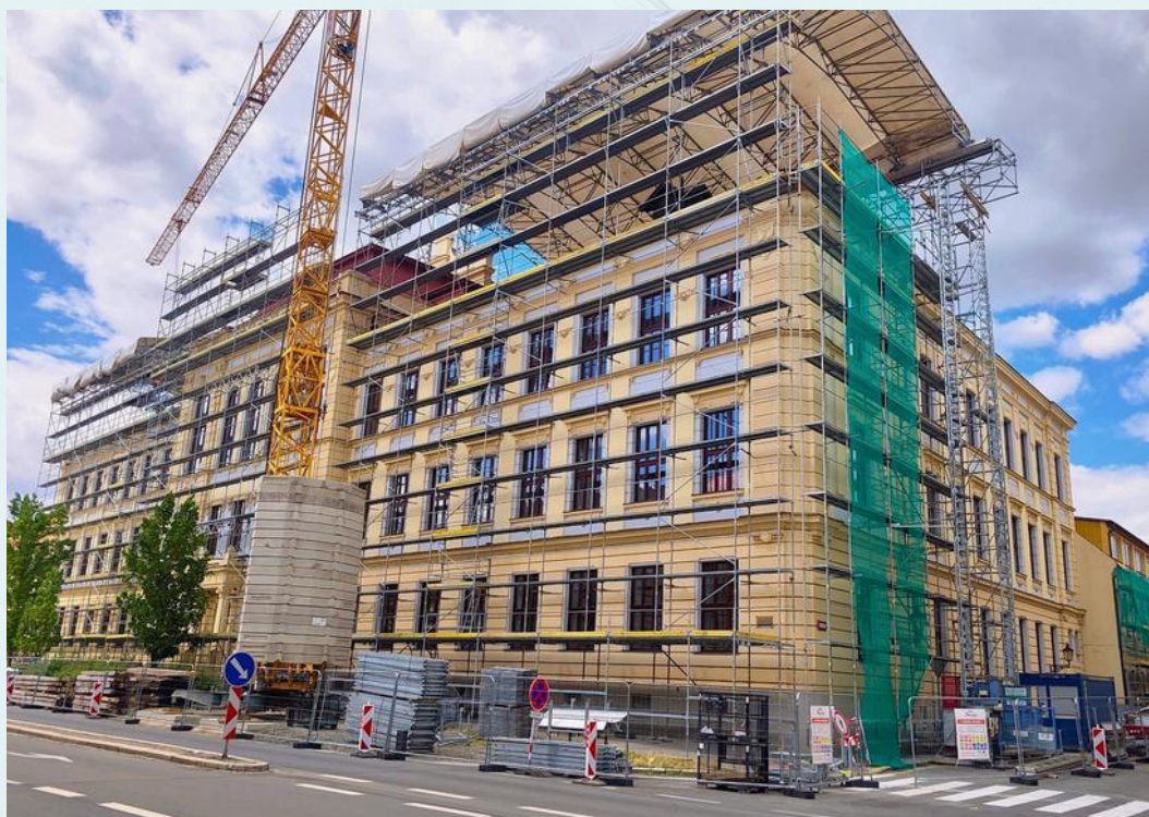
Rekonstrukce střechy školy
